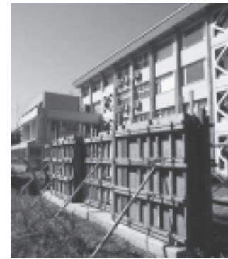
RC壁試験体(高さ3m長さ10m)
