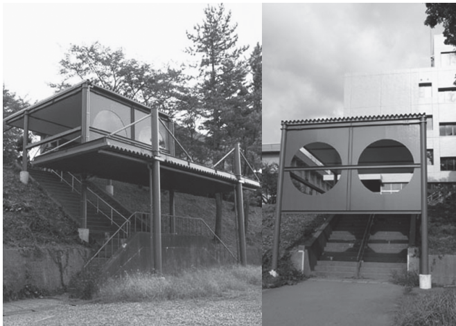
*降雪時は特に危険な急勾配階段に屋根が出来ました。
