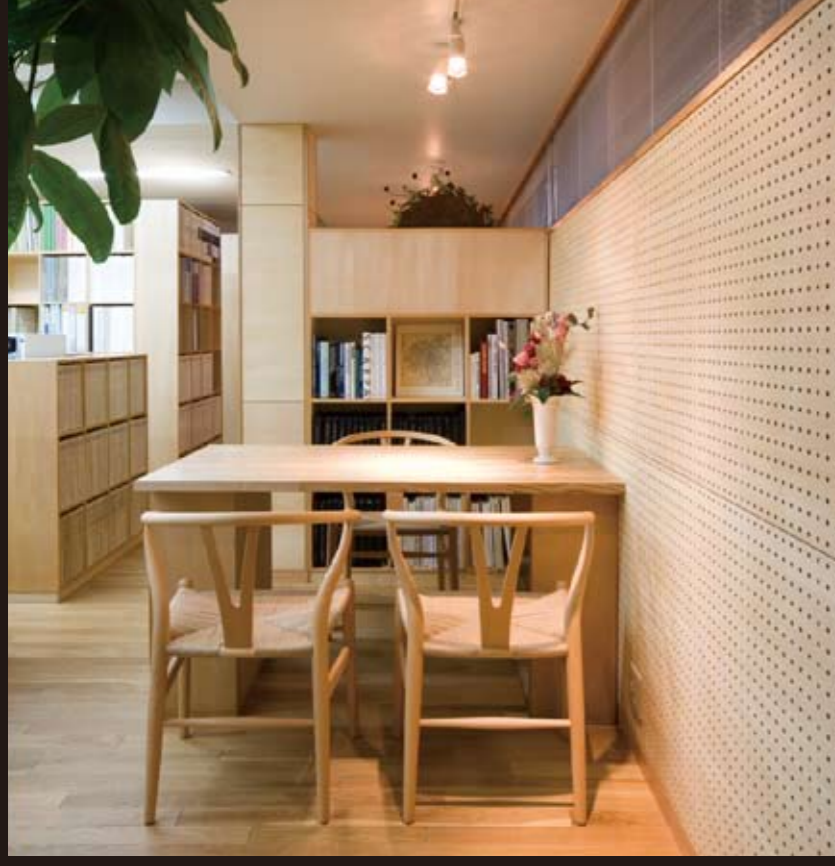
事務所併用住宅 市内商住混在する街並みとの関わり方を模索しました。 隣地住宅の採光、通風、プライバシーを確保するよう本住宅の配置を決め、隣地側全面に有孔折板を採用しています。西、南面についても同様に街との関わりを折板のスクリーンで調整しています。
