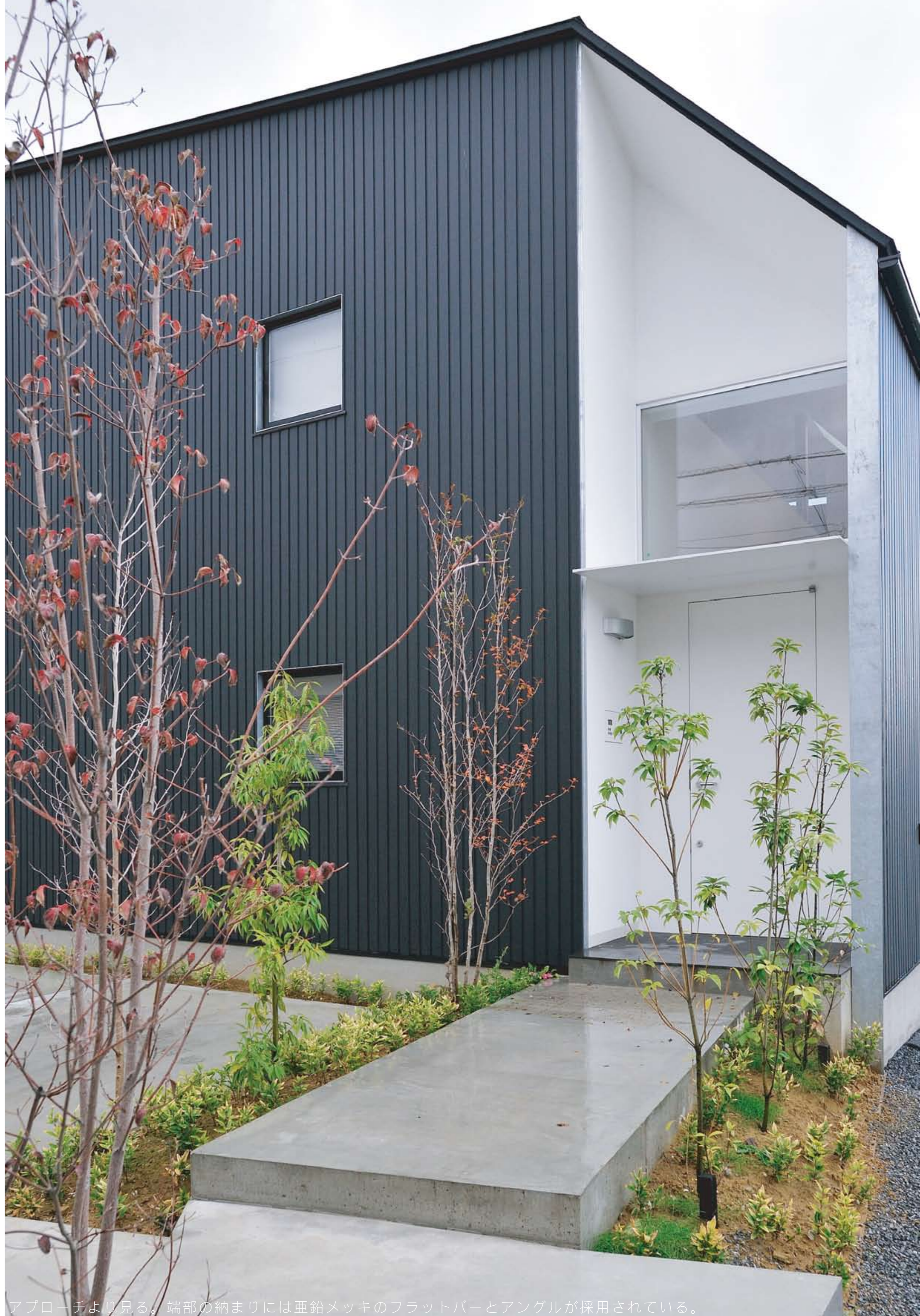
アプローチより見る。端部の納まりには垂鉛メッキのフラットバーとアングルが採用されている。
